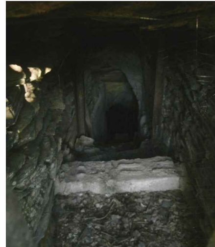
Blick in den Treppenschacht
