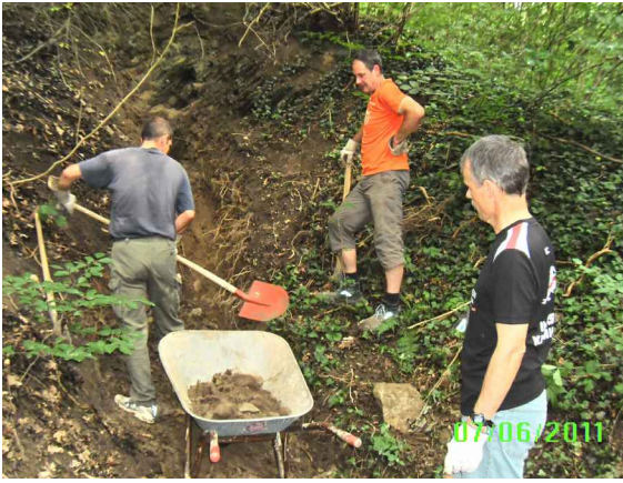
Die Arbeiten beginnen
