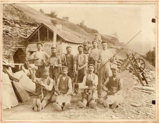
Ehemaliger Stolleneingang der Grube „Wilbert“
